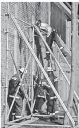
Diese Abstützung für die Außenfassade der Grundschule in Nienhagen musste durch das THW zur Sicherung nach einem Sturmschaden aufgebaut werden.
