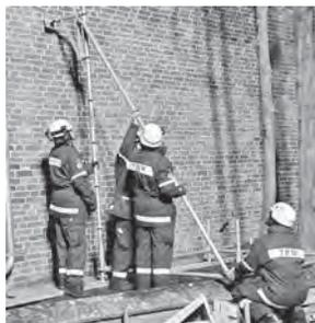
Helfer des THW aus Celle bauen gerade eine Gerüst- und Holzabstützung auf.
