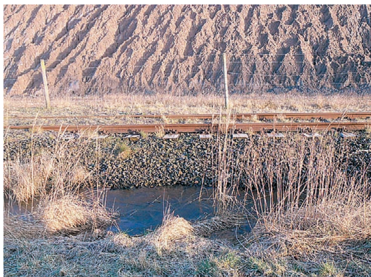
K+S leugnet relevante Auflösung der eingesunkenen Haldenbasis trotz regelmäßig hoher Grundwasserstände – hier im Februar 2016 am Haldenfuß
