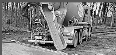
Fundamentarbeiten für die neue Garage mit Hilfe von Aller-Beton
