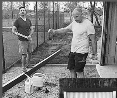
Sven und Toni beginnen mit dem Wiederaufbau und pflastern die Fläche vor der Garage
