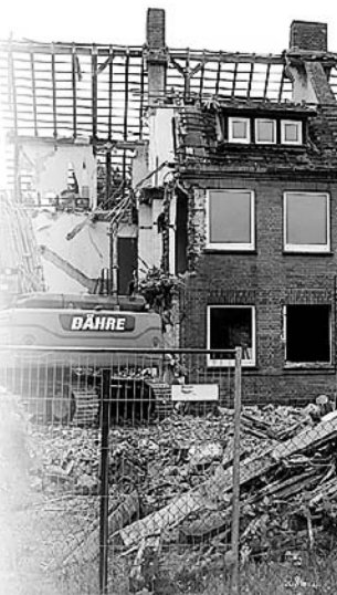
Abriss der Altimmobilie zwischen Rathaus Nienhagen und Herzogin-Agnes-Platz - hier entsteht das neue Sparkassengebäude
