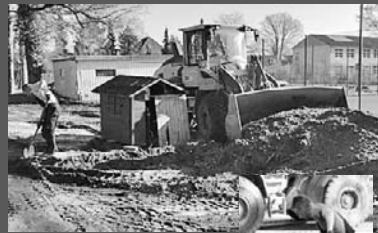
Auch hier kommt schwerstes Gerät zum Einsatz
