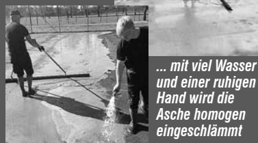
... mit viel Wasser und einer ruhigen Hand wird die Asche homogen eingeschlamm
