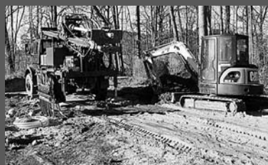
Hier wird der neuen Brunnen für die Beregnung gebohrt
