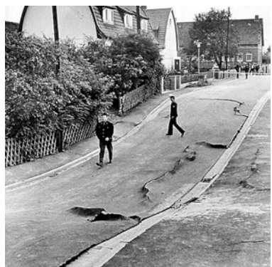
Berg-und-Talbahn: Auf der Kolberger Straße in Ronnenberg werden die Auswirkungen der Erdfälle sichtbar.
