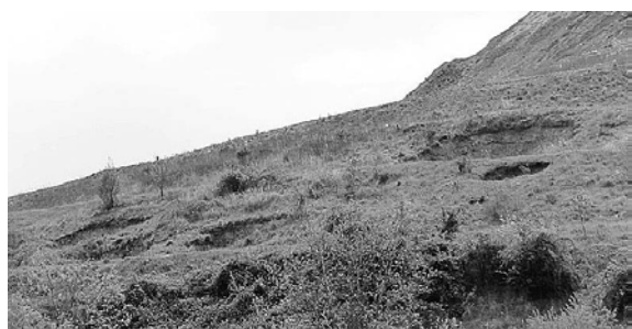
Großflächige und tiefe Versackungen an der abgedeckten Kalirückstandshalde in Sehnde
